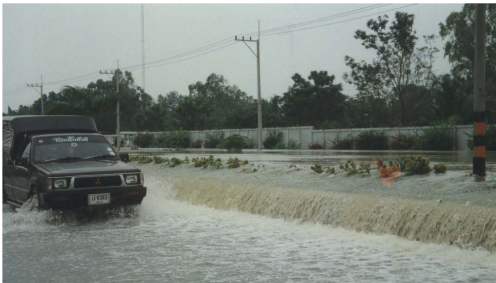
ภาพ พายุ “ลินดา” ปี พ.ศ. 2540 น้ำท่วมเส้นทางคมนาคม ปราณบุรี - สามร้อยยอด จังหวัดประจวบคีรีขันธ์
