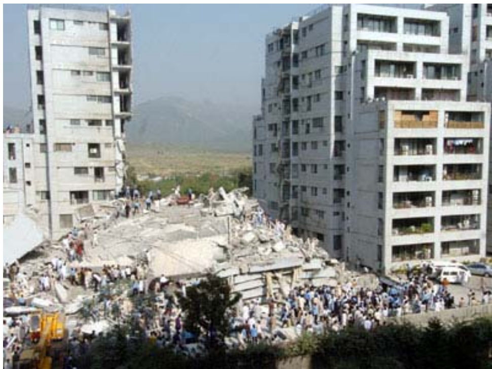
แผ่นดินไหว ขนาด 8.1 ริกเตอร์ ทำให้อาคารถล่ม
