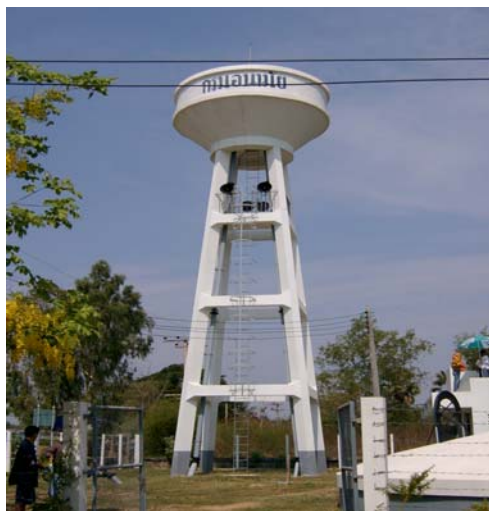
รูปที่ 22 หอถังสูง
