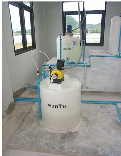
รูปที่ 36 ตัวอย่างเครื่องและระบบจ่ายสารละลายคลอรีน
