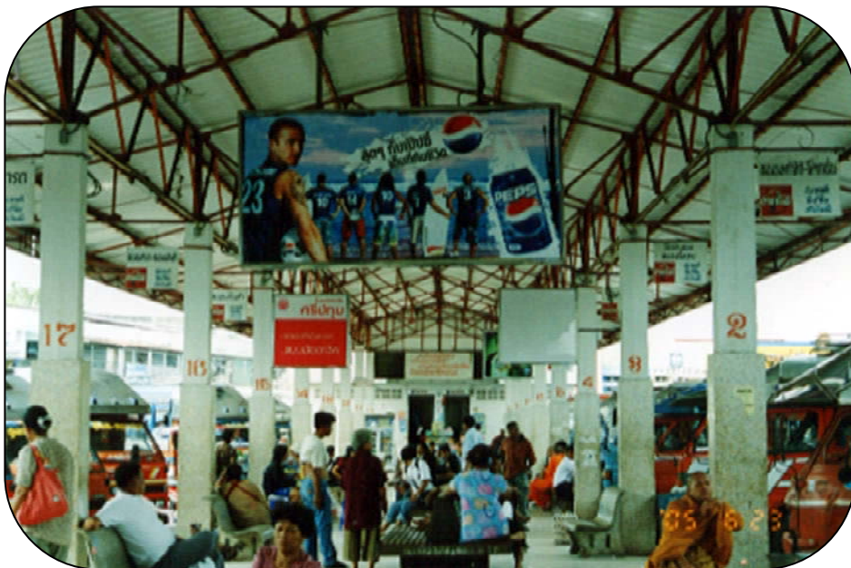
รูปที่ 2.29 การติดตั้งป้ายโฆษณาภายในลานขาลาสถานีขนส่ง
