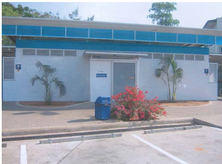
ห้องน้ำสาธารณะในบริเวณสถานีบริการน้ำมัน
